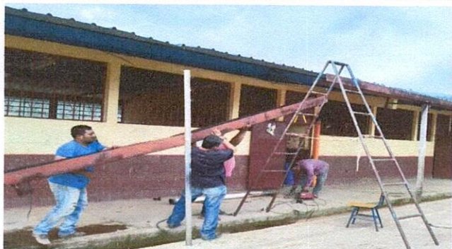
Foto 3: Sustitución de canales de metal.
