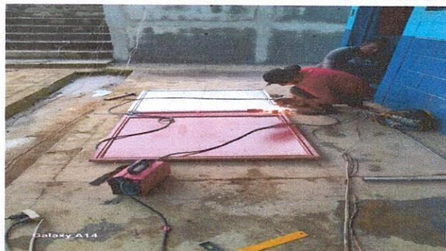
Foto1: Mantenimiento a estructura, lijado, cambios de tuvos, aplicación de pintura a puertas de metal.
