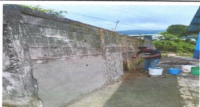
Foto 6: Aplicación de repello de muro de contención.
