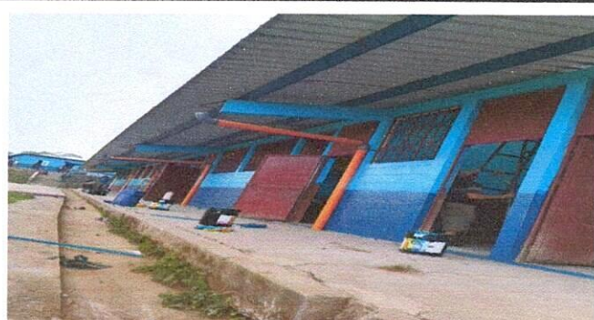
Foto 4: Pintura de muros exteriores y interiores de la escuela.
