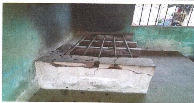
Foto 5: Sustitución de estufa natural completa.
