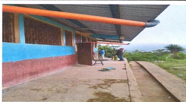
Foto 2: Reparación de piso de torta de cemento.
